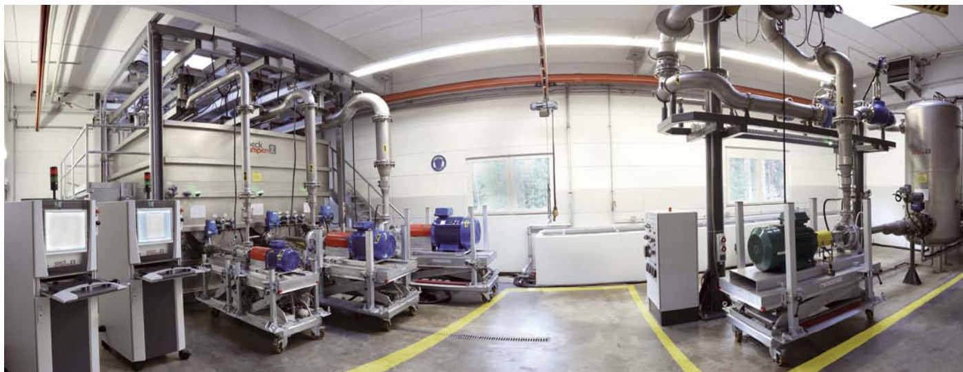
Bancs d'essai pilotés par ordinateur et complètement automatisés à l'usine de Speck à Roth. Mesure des paramètres hydrauliques, des besoins en puissance, de la poussée axiale, des vibrations et des valeurs NPSH. Possibilité d'atteindre des hauteurs de refoulement allant jusqu'à 400 m et des débits de refoulement de jusqu'à 750 m 3 /h.
